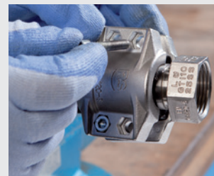
9) Před montáží odmastit závity všech šroubů. Objímku rovnoměrně stáhnout 2 delšími pomocnými montážními šrouby do kříže.
